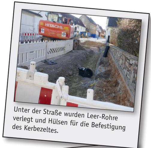
Unter der Straße wurden Leer-Rohre verlegt und Hülsen für die Befestigung des Kerbezettes.
